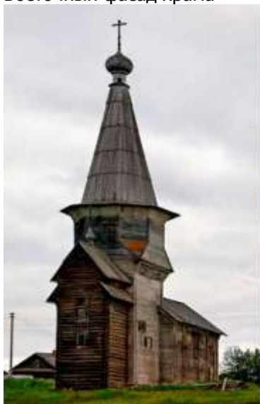
Восточный фасад храма
