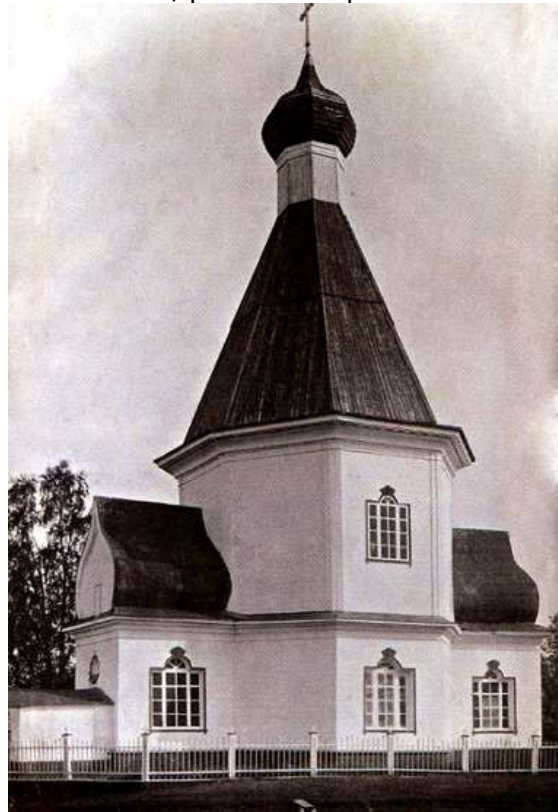
Никольская церковь после ремонта 1886 г.
