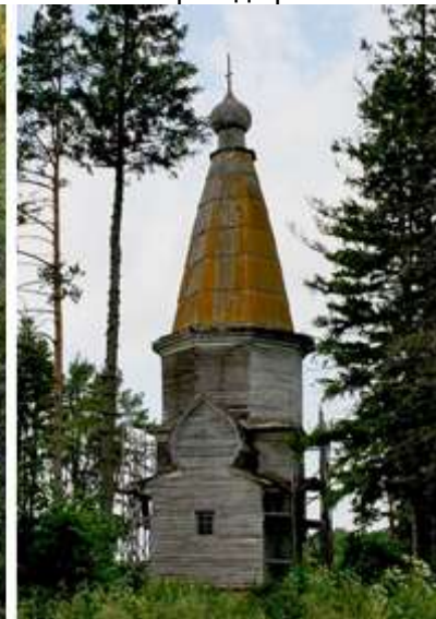
Восточный фасад храма
