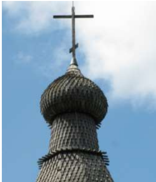
Главка, барабан и шатер
