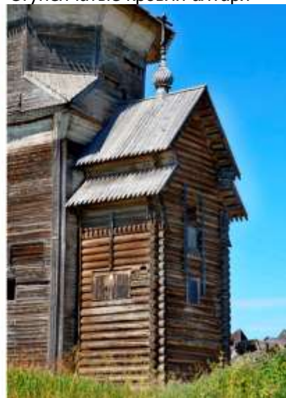
Ступенчатые кровли алтаря
