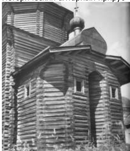
Исторический алтарный прируб
