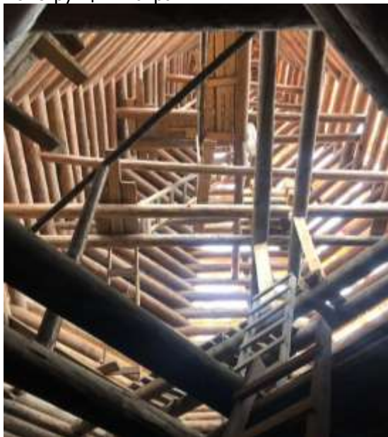
Конструкция шатра
